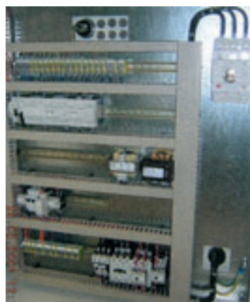
图 3 Streamline 超高压泵控制柜
