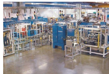
图二：SHP一体式控制器在汽车零配件组装线现场
